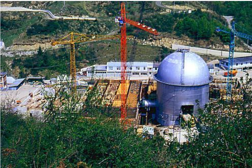
La centrale PEC del Brasimone (Castiglion dei Pepoli-BO) mai completata
